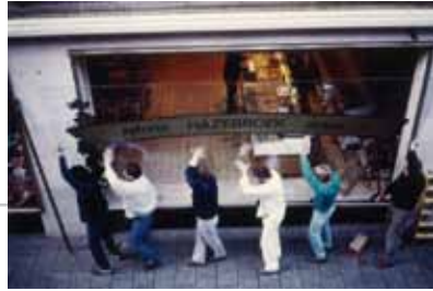
▲ Met zes mensen een etalageraam plaatsen in de jaren tachtig. In de witte overall is Burggraaff zichtbaar.
